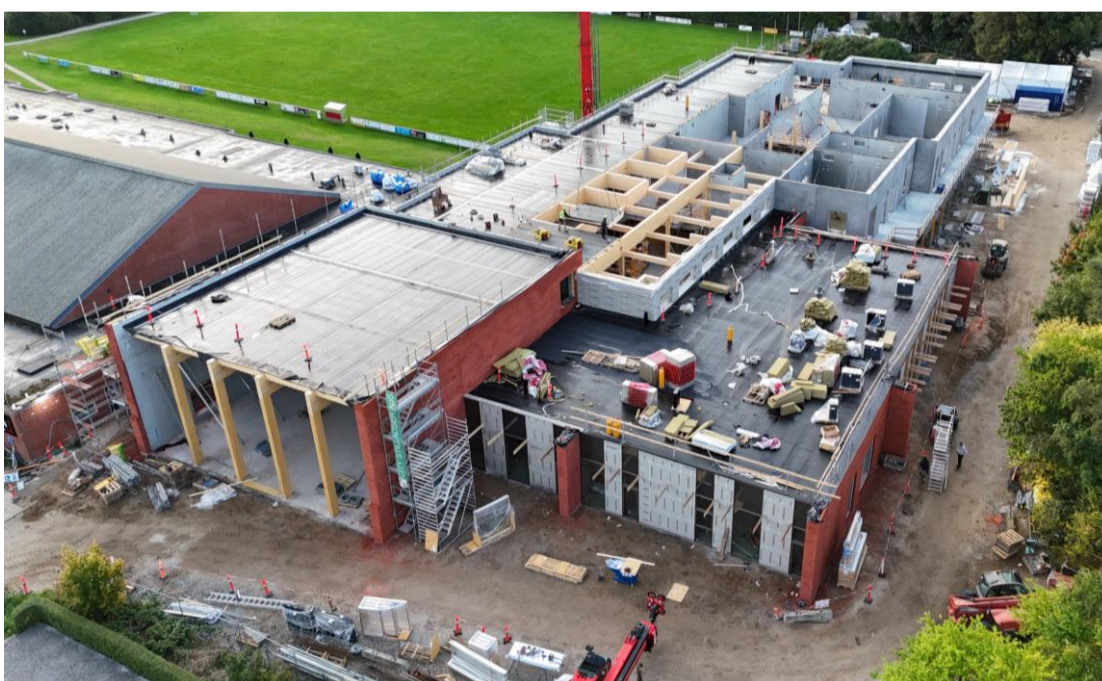
Figur 2: Foto af byggepladsen fra luften. Foto taget d. 25-09-2024
