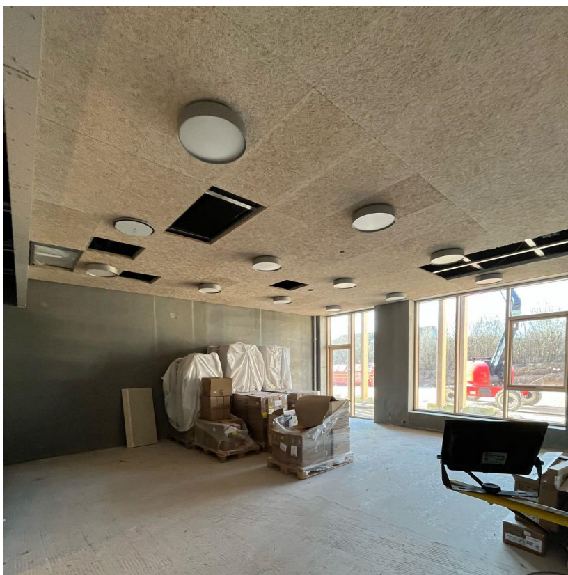
19-02-2025. Figur 1: Foto af loft- og lampemontage i Projektrum.
